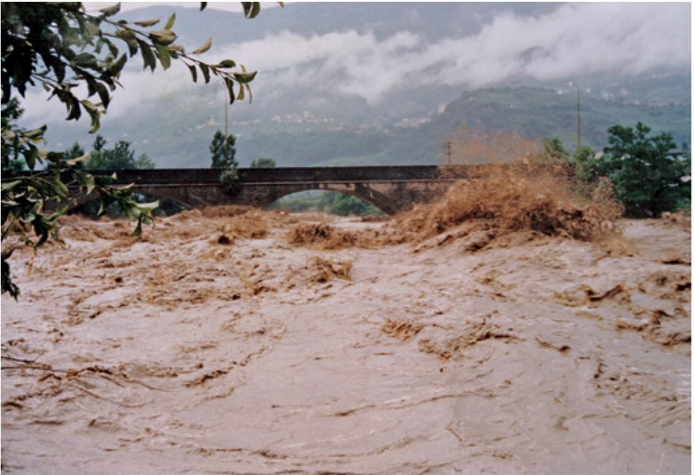
19 Luglio 1987 Ponte della Streppona - L'impressionante piena dell'Adda fa vibrare il ponte; massi e piante colpiscono i piloni creando sbarramento aumentando il livello.
